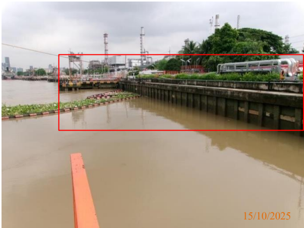
รูปที่ 2-1 เชื้อนคอนกรีตตลอดแนวท่าเทียบเรือ
