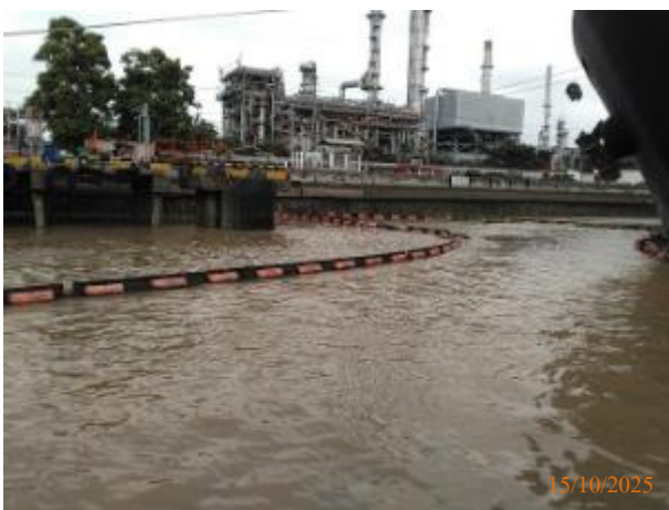
รูปที่ 2-5 ทักน้ำมัน (Boom) อุปกรณ์ป้องกันการแพร่กระจาย กรณีเกิดการหกรั่วไหล
