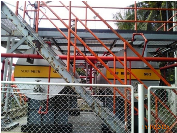
รูปที่ 2-3 Slop System สำหรับรองรับน้ำมันหกรั่วไหล
